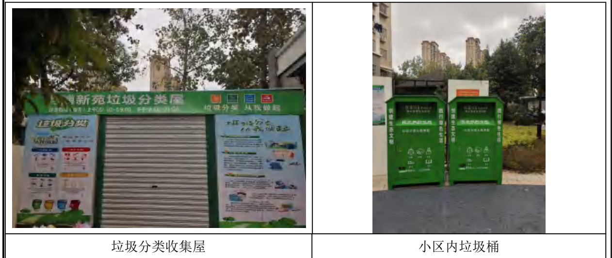
图 3 项目区域内固体废物处置设施
