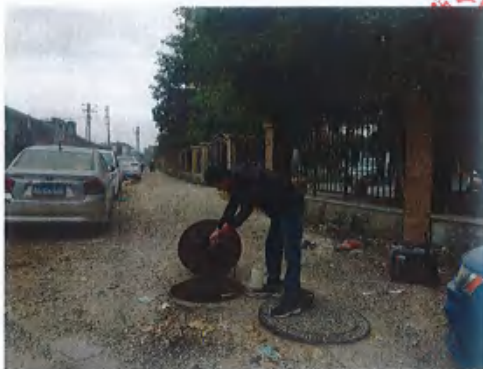
图 6 生活污水排放口
