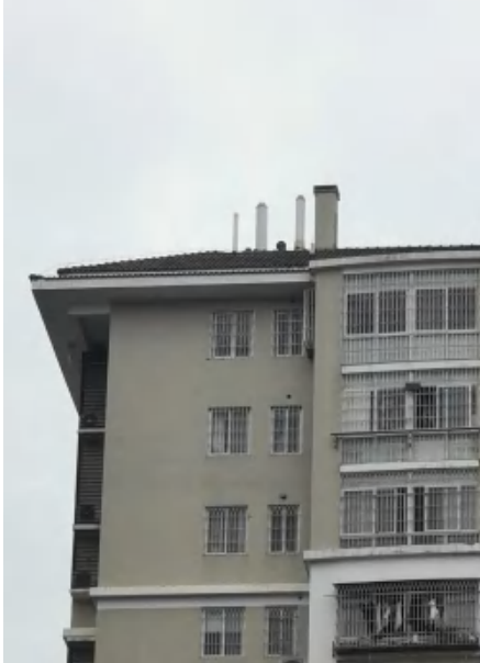
住宅油烟废气排放口（位于屋顶）
