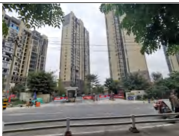
项目西侧（后坂新城-四区）
