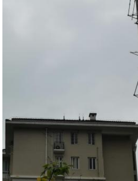
住宅油烟废气排放口（位于屋顶）
