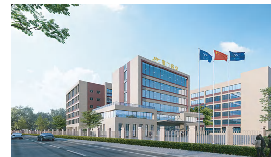
厦门嘉鹭金属工业有限公司嘉鹭智能制造控制中心项目（建筑面积5.4万平方米）
