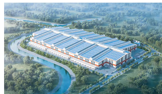
云霄奥克兰年产8万吨取向硅钢项目
