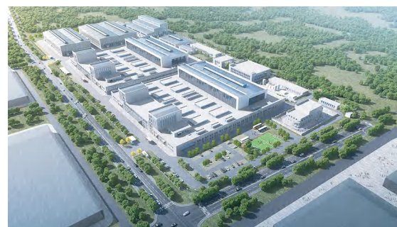
唐山亨坤新能源材料有限公司50000吨环境 友好型磷酸铁锂项目
